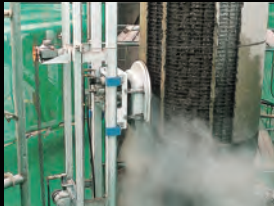
橋脚の劣化コンクリートのはつり
