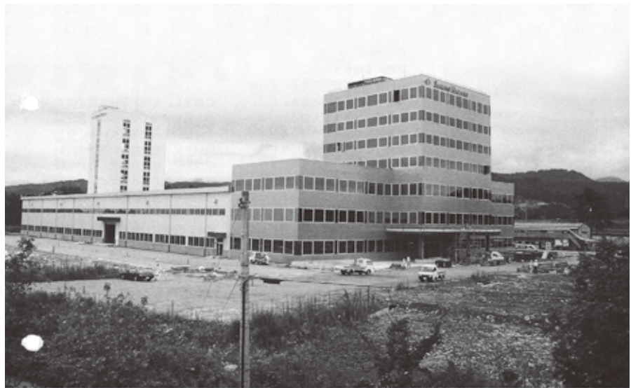
1993年10月に稼働した早月工場
