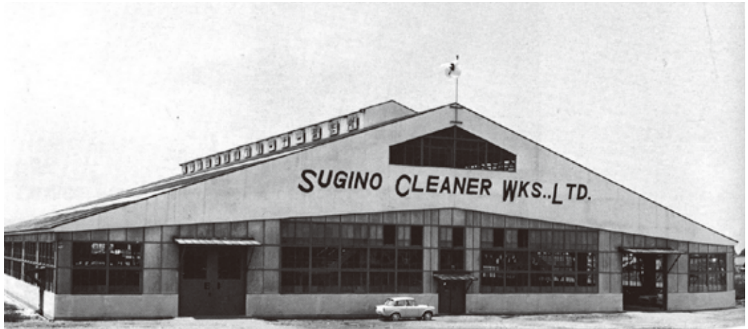
トラス工法を採用入れて完成した魚津第1工場
