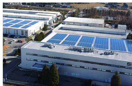
滑川事業所に設置した太陽光パネル
